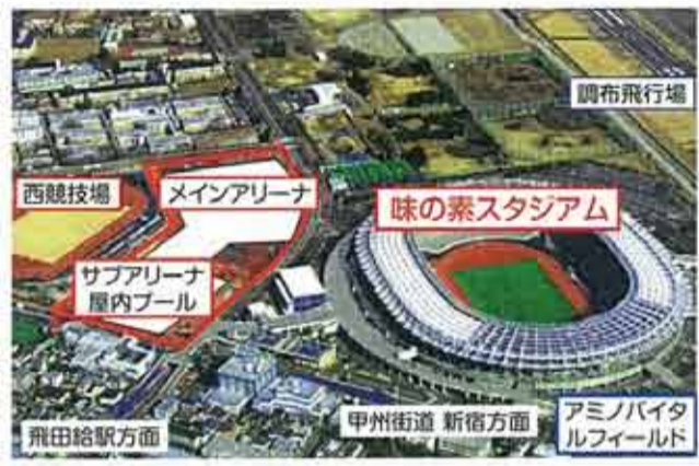
建設工事が進む東京スタジアム(味の素スタジアム)周辺
